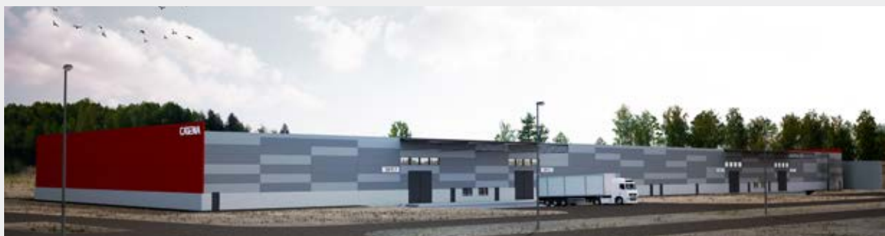
Volymterminal, Katrineholm, under uppförande
